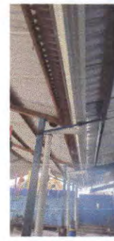
Foto 2: Sustrución de canal y sustrución de bajada de agua pluvial de metal por tubo 3"
