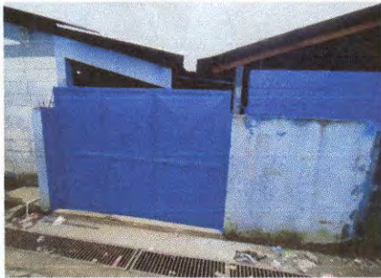
Foto13: Sustitución de portón de metal
