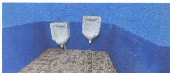
Foto 9: Sustrucción de mingitorio
