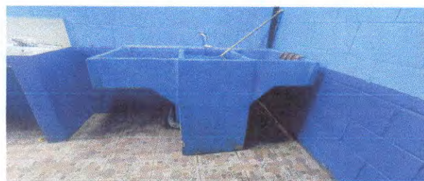
Foto 12: Sustrucción de pila de cemento
