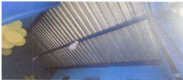
Foto 3: Sustrución de lámina, por lámina troquelada aluzinc calibre 26
