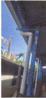
Foto1: Sustrución de canal y sustrución de bajada de agua pluvial de metal por tubo pvc 3"
