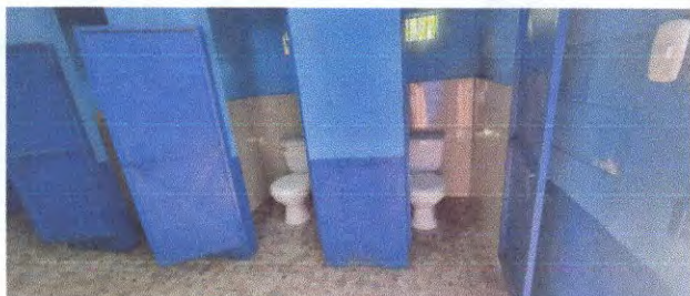
Foto 7: Sustrucción de inodoro
