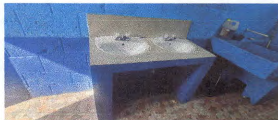
Foto 8: Sustrucción de lavamanos
