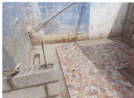
Foto 10: Sustrucción de torta de concreto
